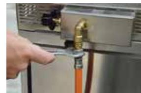
Прикрутите газовый шланг к газовому редуктору. Модель гриля In&Out оснащена блокировкой подачи газа в случае разрыва шланга. Этот элемент системы безопасности должен быть прикручен между шлангом и редуктором. Стрелка на корпусе данного элемента показывает направление движения газа, от балона к грилю.
